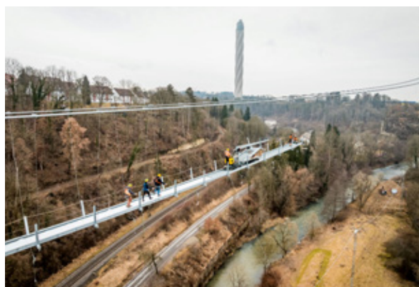
Abb. 4: Seile Spannen und setzen des Laufstegs
