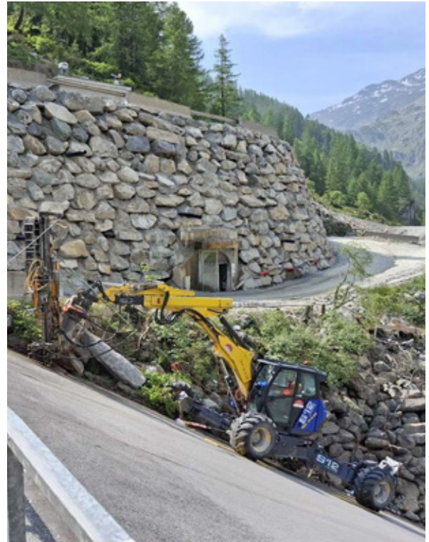
Auch ein Kaiser Mobil-Schreitbagger S12 Allroad unterstützte die Arbeiten am Wurtendamm.
