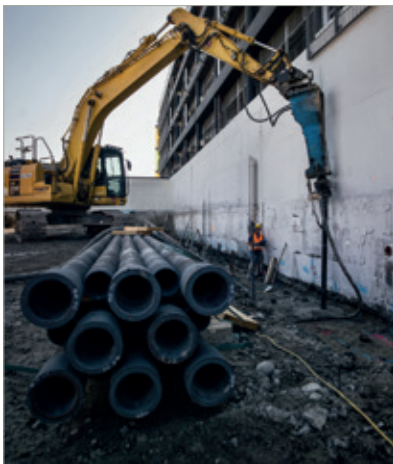
Um den enormen Verschleiß zu reduzieren wurden verschiedene Maßnahmen gesetzt. Zum Einsatz kam ausschließlich Felsbohrwerkzeug.
