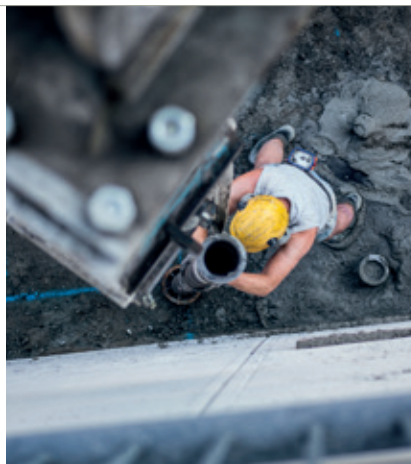
Um den enormen Verschleiß zu reduzieren wurden verschiedene Maßnahmen gesetzt. Zum Einsatz kam ausschließlich Felsbohrwerkzeug.
