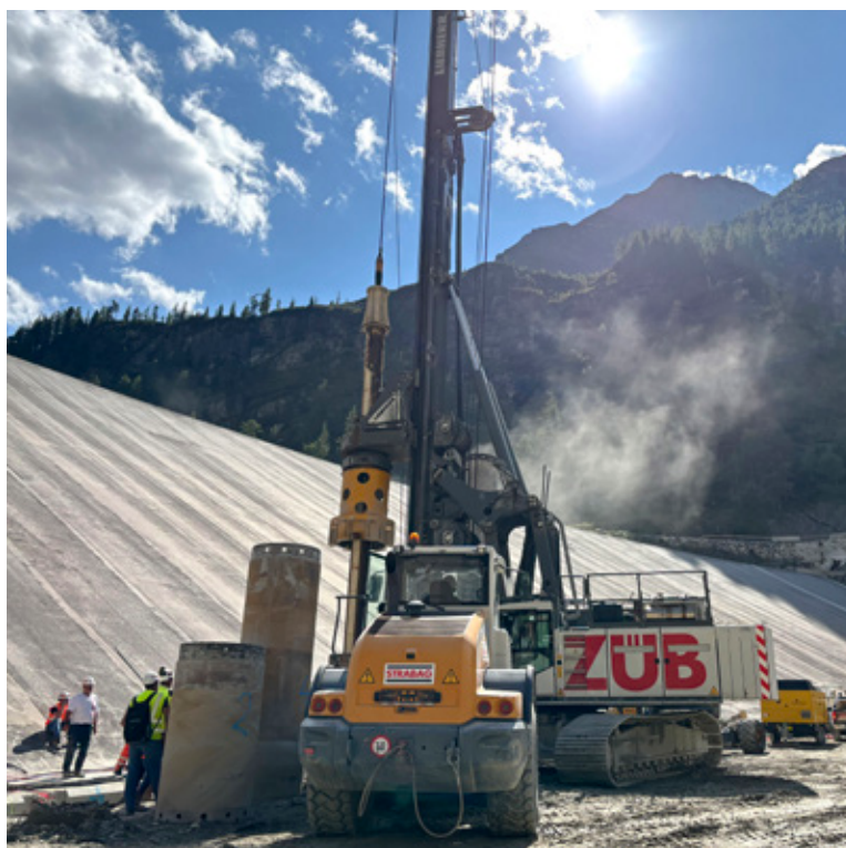
Das Liebherr LB 45 Drehbohrgerät bei der Herstellung der überschnittene Bohrpfahlwand.
