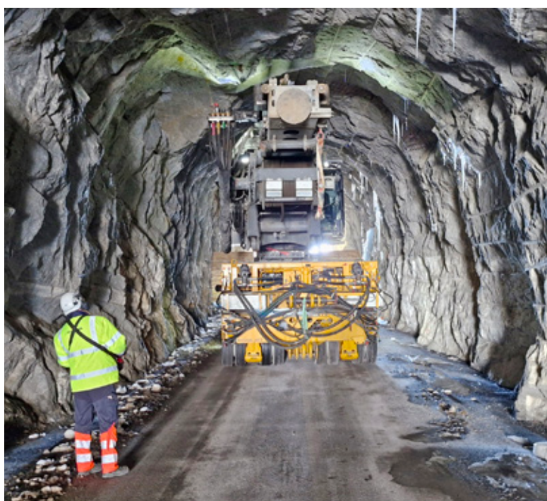
Der Transport der Großgeräte über die schmale Bergstraße erfolgte durch Selbstfahrer und Tieflader.
