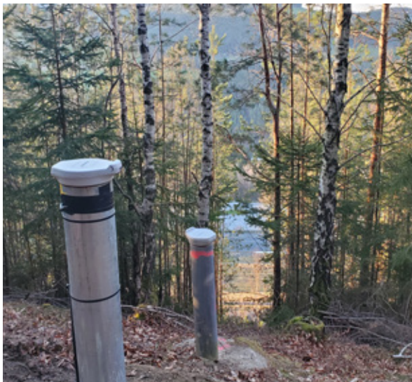
Abb. 5: Fertig installiert an der Böschung – FBG-Inklinometer
