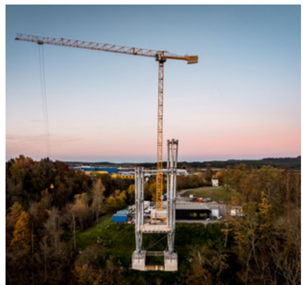
Abb. 2: Drohnenaufnahme Widerlager Steigkapelle mit Betriebsgebäude und dem rd. 60 m hohen Pylon.
