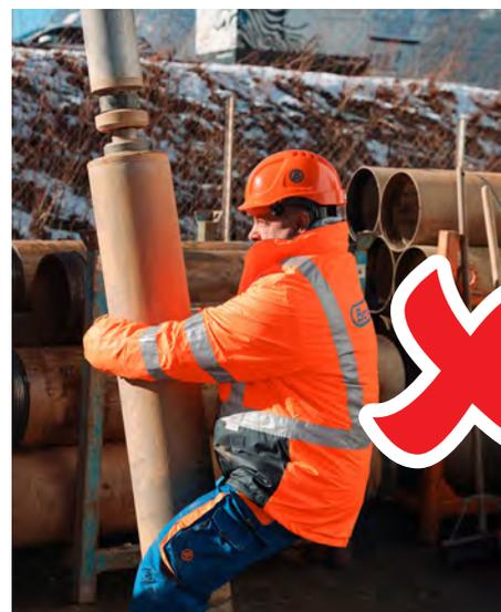
Abb. 6: Falsche Manipulation Kernrohr
