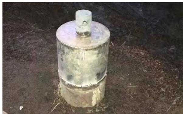
Abb. 3: Abdecken, Verschluss der Bohrung
