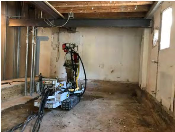
Düsenstrahlverfahren unter beengten Platzverhältnissen
