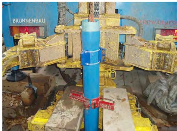
Abb. 2: Hebekappe und Abfangschelle beim Pegelrohrreinbau
