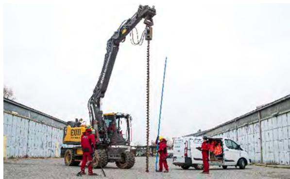
Abb. 05 Bohrlochsondierung punktuell
