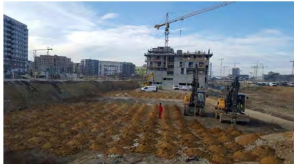
Abb. 04 Bohrlochsondierung flächendeckend
