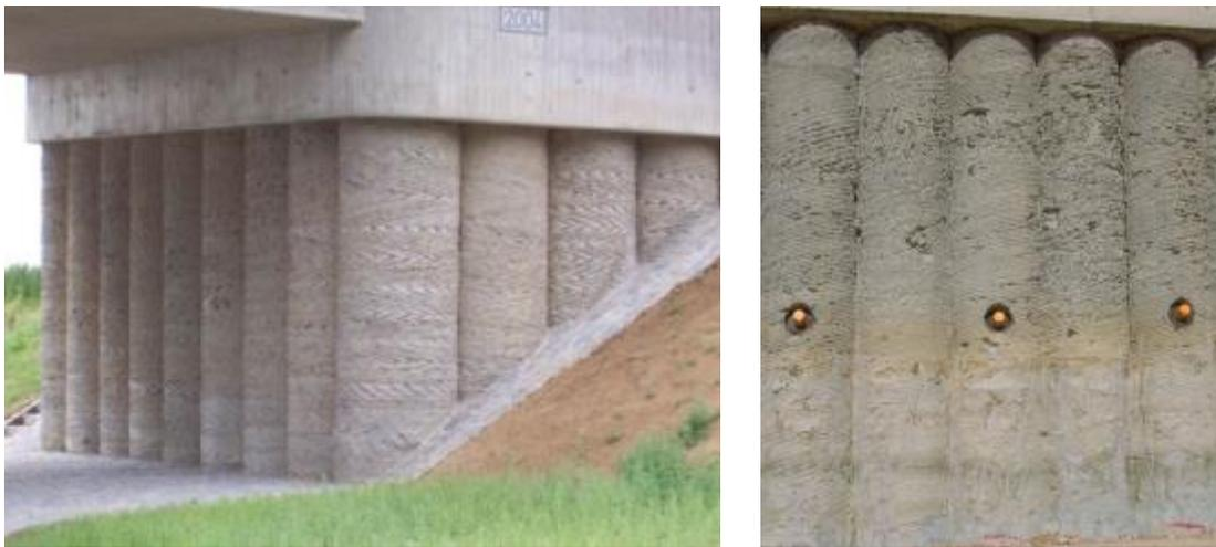
Eine gründliche Interpretation der Imperfektionen sollte von einem erfahrenen Spezialisten für geotechnische Arbeiten durchgeführt werden, der dann objektiv abschätzen kann, ob eine Imperfektion eine Fehlstelle oder eine Abweichung ohne schädigenden Einfluss auf die Tragfähigkeit oder die Dauerhaftigkeit darstellt. Die folgenden Abschnitte können bei der Interpretation und Beurteilung von Imperfektionen hilfreich sein.
