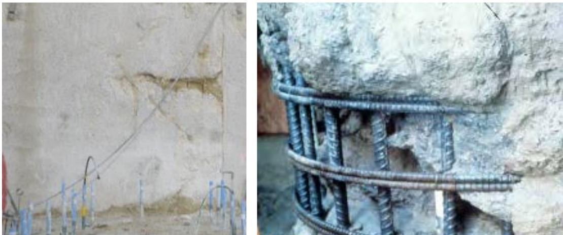
Einschlüsse werden üblicherweise als hinnehmbar angesehen, wenn diese in Ausmaß und Anzahl begrenzt sind. Nur wenn das Ausmaß dergestalt ist, dass die Tragfähigkeit beeinträchtigt wird oder
