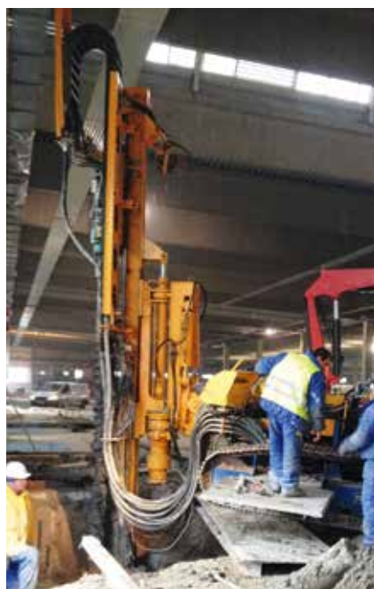
Mikropfähle Rewe Wr. Neudorf.
