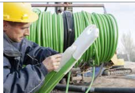
In Mittweida kamen die Erdwärmesonden RAUGEO PE-Xa zum Einsatz.
