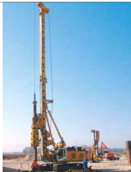
Bohrpfähle Hofer Sattledt.
