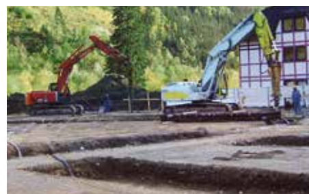
Duktülpfähle Wildbad Einöd.
