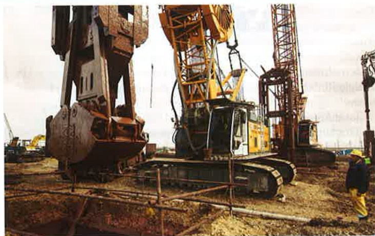
Schlitzwandarbeiten eines Seilbaggers vom Typ HS 8100 HD beim Suezkanal nahe der ägyptischen Stadt Port Said.
