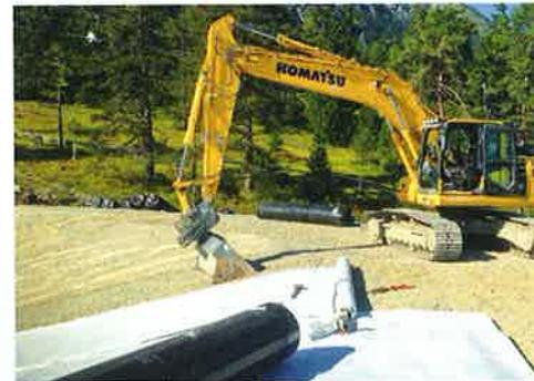
**Für den Bau eines Speicherteiches wurde ein kürzlich erworbener Hydraulikbagger von Komatsu eingesetzt**
