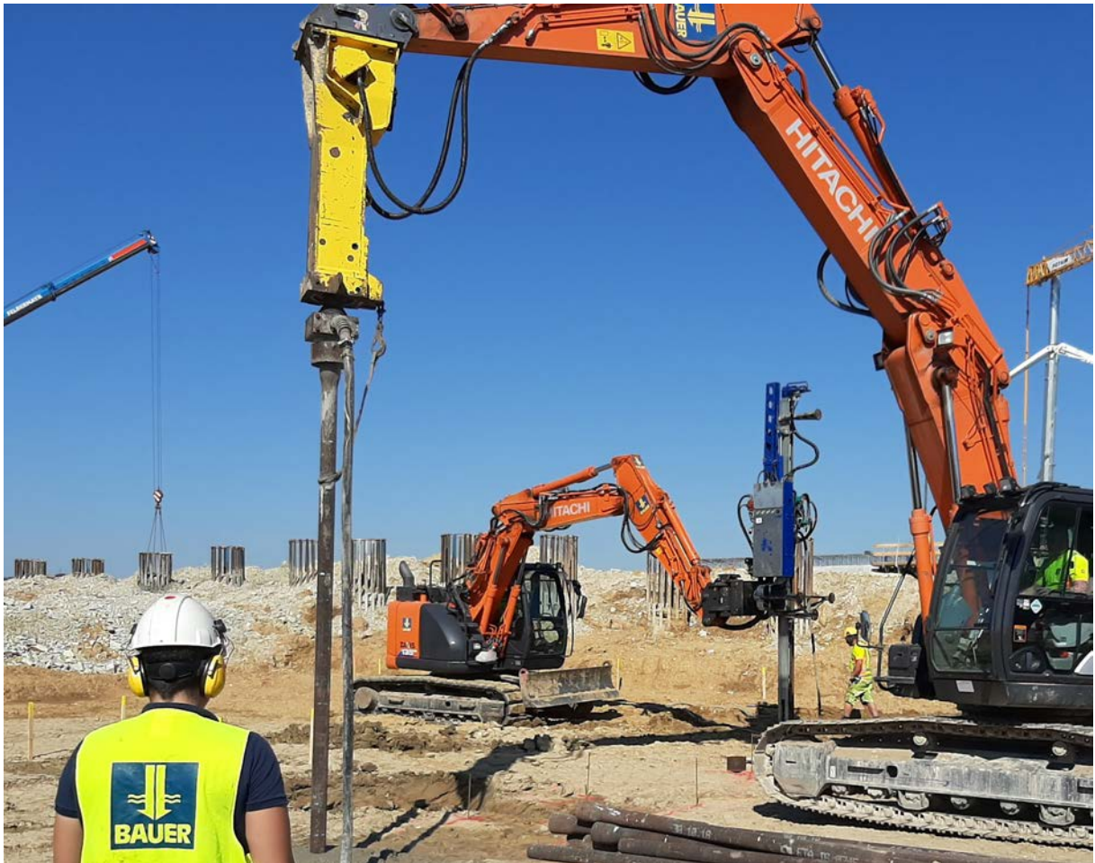
Herstellung duktiler Pfähle für statische Probelastung
