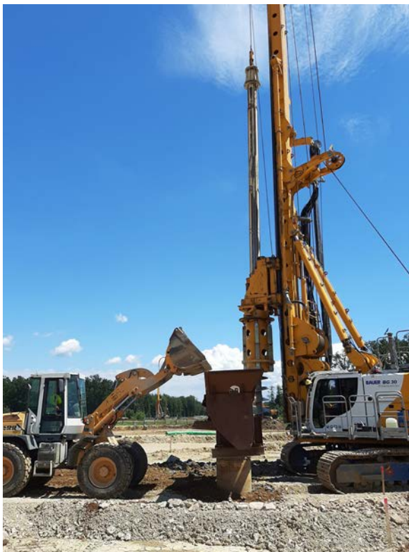
BAUER BG 30 bei der Herstellung von Kiespfählen
