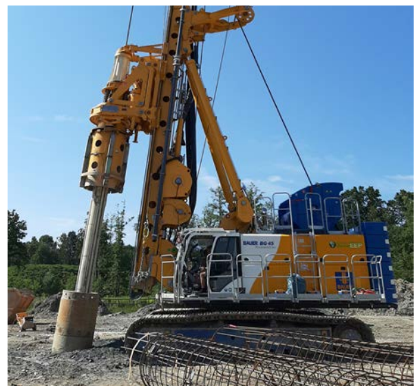
BAUER BG 45 bei der Herstellung von Schrägpfählen
