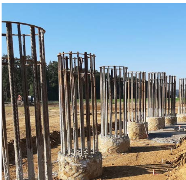
Fertiggestellte Pfähle für eine integrale Brücke
