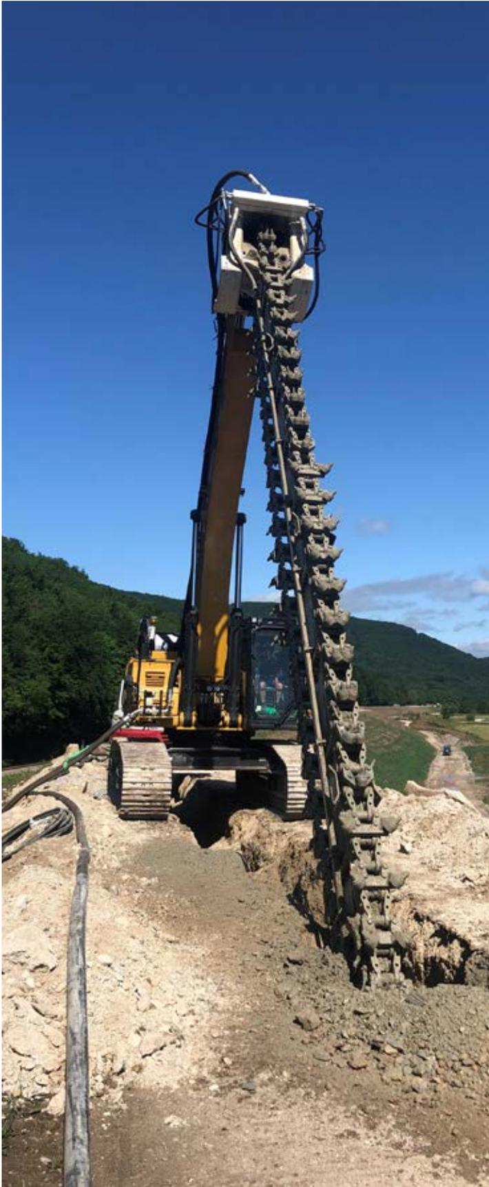
Die große 10m-Fräse beim Eintauchvorgang in den Dammkörper
