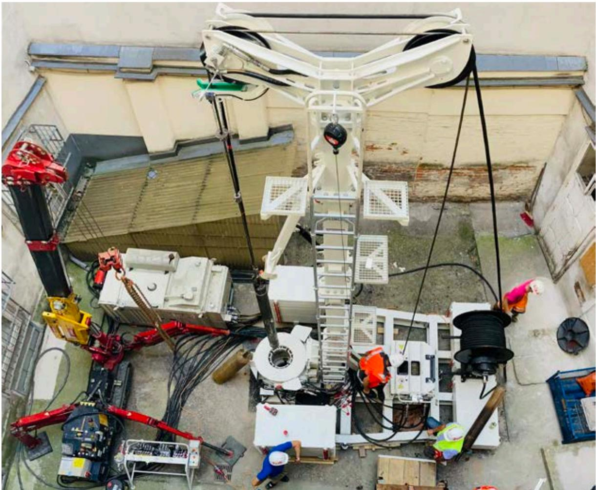
Abb. 4: Baustelleneinrichtung während der Bohrarbeiten
