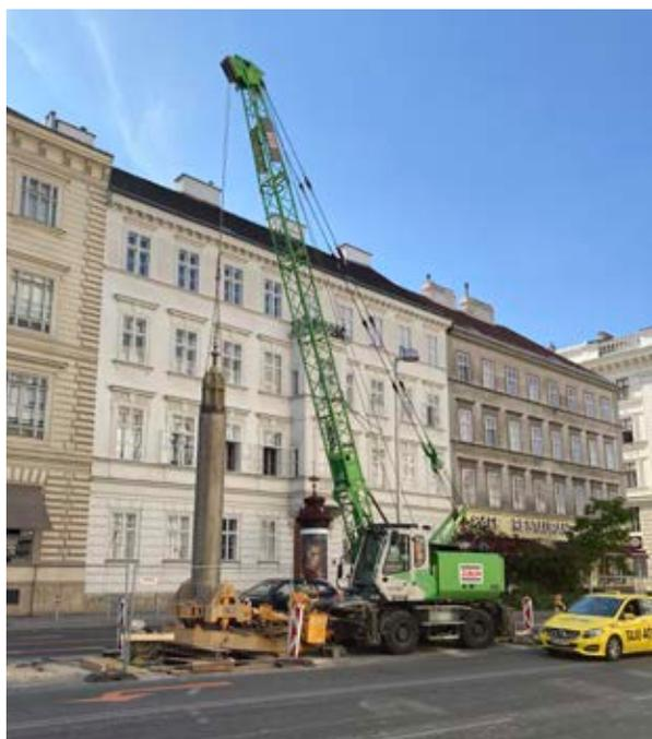
Abb. 1a+b: Greiferschlagbohrung DN 640 mm mit Seilbagger
