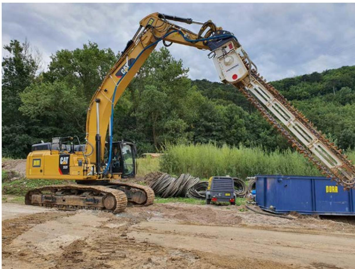
Die Herstellung des unteren Abschnitts erfolgte mittels 5m-Fräse
