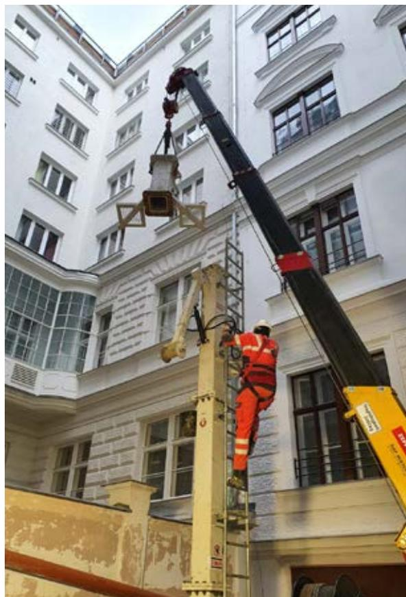
Abb. 2: Aufbau des Bohrturms (Mastmontage)
