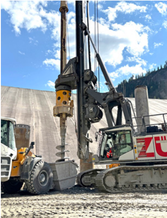
Um den enormen Verschleiß zu reduzieren wurden verschiedene Maßnahmen gesetzt. Zum Einsatz kam ausschließlich Felsbohrwerkzeug.
