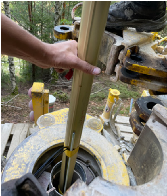
Abb. 4: Einbau des FBG-Inklinometers ins Bohrloch – der flexible Sensorstab wird abschnittsweise eingeführt
