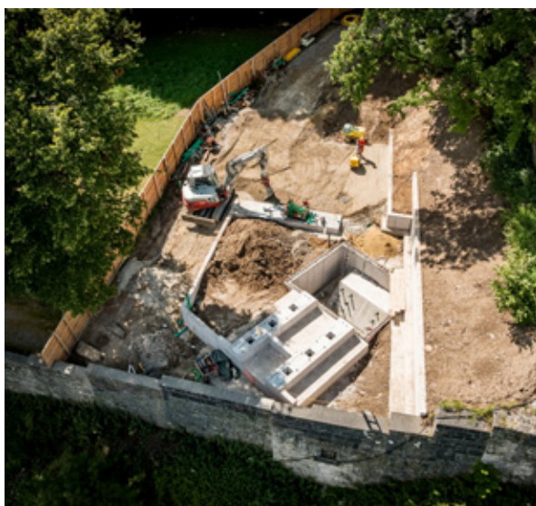
Abb. 3: Widerlager Bockshof, Anbindung an die Stadt Rottweil
