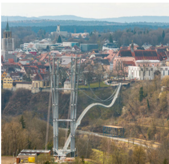
Abb. 1: Drohnenaufnahme der Fertiggestellten „Neckarline“
