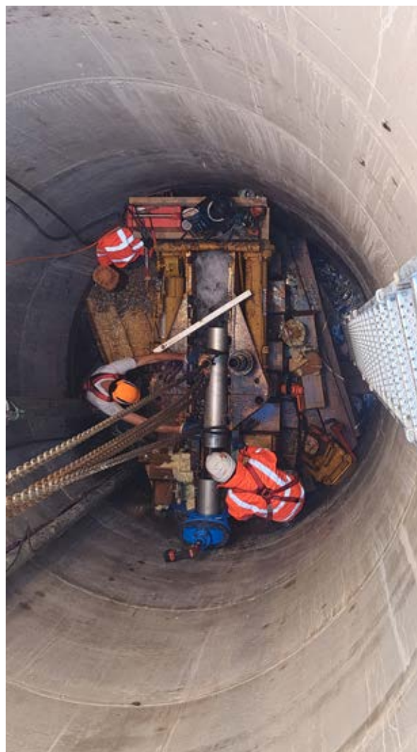
Abbildung 4: Vortreiben der Rohre im System Ranney-Fally
