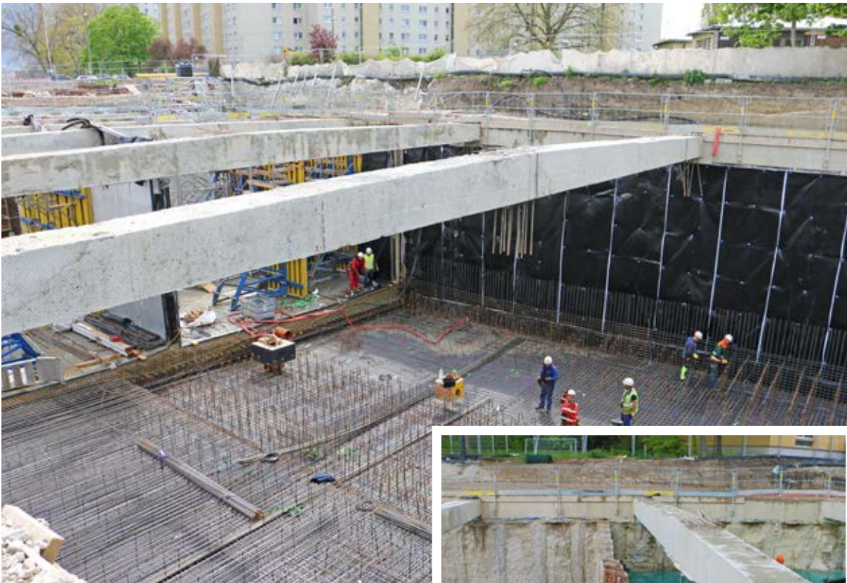
In den Bereichen im Baulos 3, in denen das Grundwasser bereits abgepumpt werden konnte, läuft der Ingenieurbau bereits auf Hochtouren. Rechts die Spundwand zwischen Schott 8 und 9.
