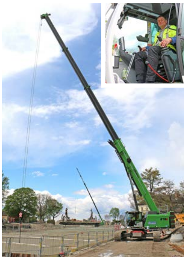
Maschinist Soltan Szűsz (Firma PORR) schätzt die Qualitäten des Multitasking- Meister Sennebogen 673 E: Lasten drehen, schwenken, verfahren, heben, punktgenau absetzen und das Ganze in Schräglage. Möglich durch 360°-Schwenks, stufenloses Teleskopieren und Verfahren mit bis zu 100% Last.
