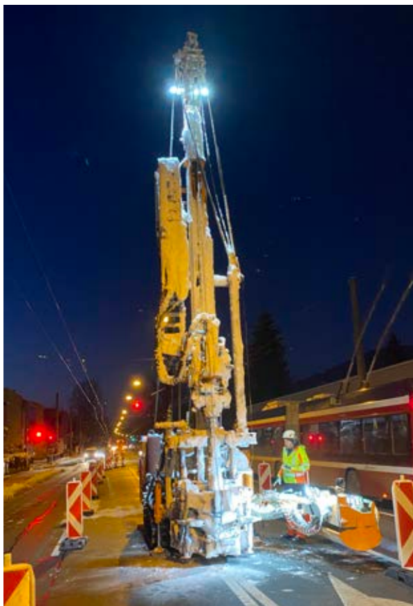
Abb.: Bohrbetrieb in der Alpenstraße – der O-Bus kann ungehindert passieren
