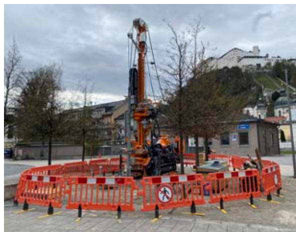
Abb.: Bohrstelle mit Blick auf die Festung Hohensalzburg
