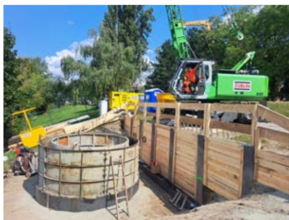
Abbildung 2: Senkschneide mit Schalung für den ersten Betonierabschnitt
