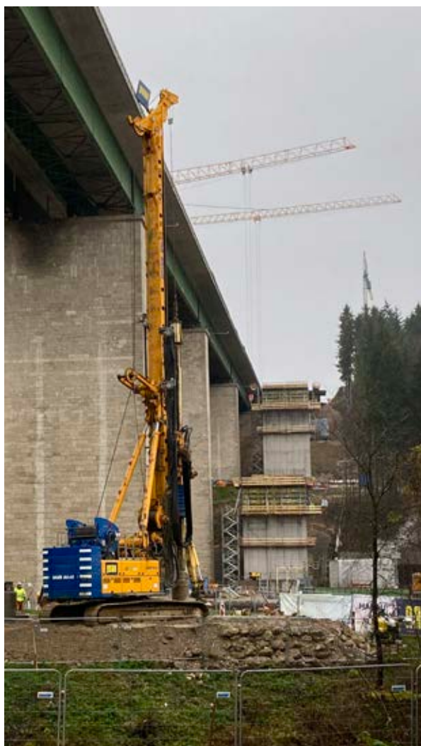
Bohrarbeiten für die Behelfsbrücke im Nahbereich der Bestandspfeiler
