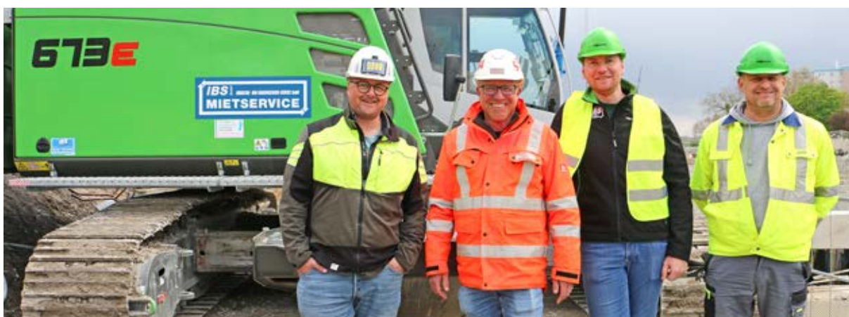
Der Telekran 673 E ist eine wichtige Unterstützung für den Ingenieurbau im Baulos 3 (von links): Roland Schelch (PORR, Bauführer der Baulose 3 + 4), Mario Hofer (STRABAG, Polier Baulos 3), Joseph Warum (Leiter der Niederlassung IBS Austria) und Soltan Szűsz (PORR, Maschinist des Sennebogen 673 E).
