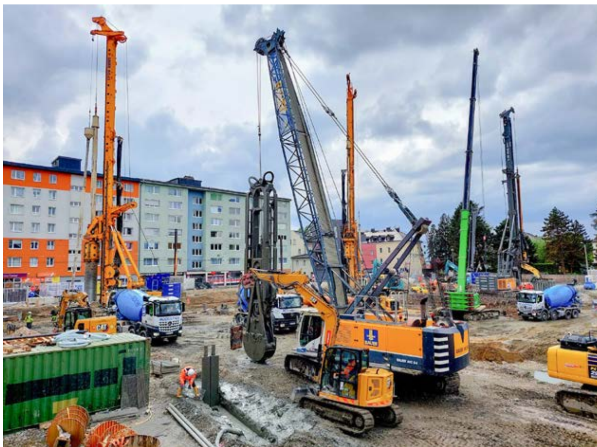
Abb. 1: Eine Schlitzwandereinheit plus drei Großdrehbohranlagen mit Nebengeräten gleichzeitig tätig
