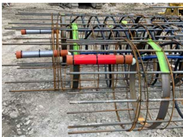
Abb. 5: Erdwärme-Leitungen am Bohrpfahl-Bewehrungskorb
