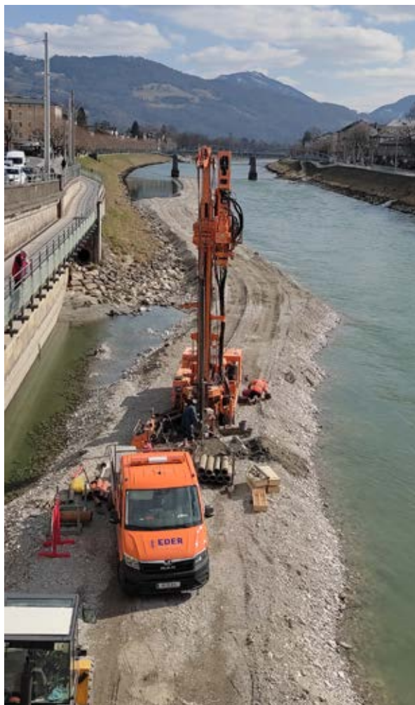
Abb.: Ponton-Ersatzbohrung in der Salzach
