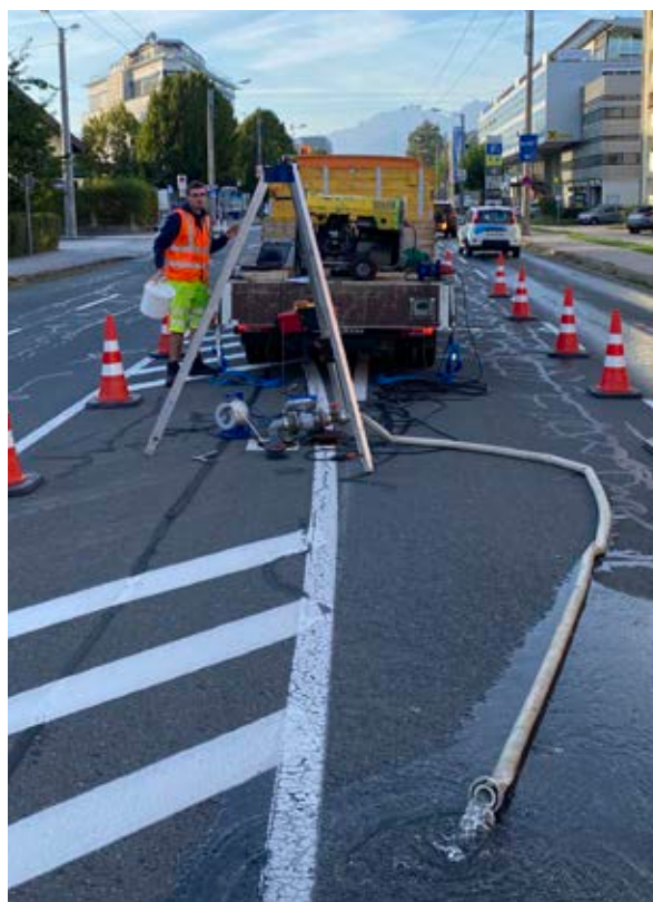
Abb.: Pumpversuch unter fließendem Verkehr
