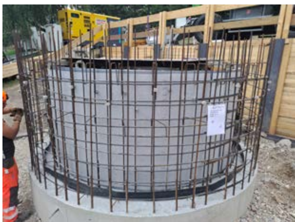
Abbildung 3: Herstellung der Bewehrung eines Ringes
