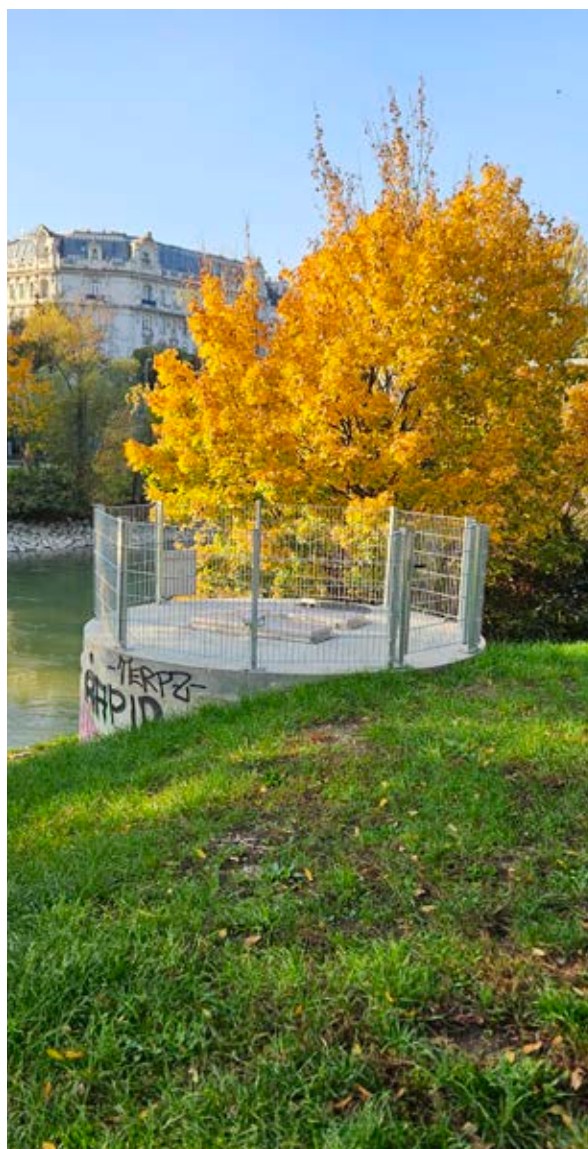
Abbildung 6, rechts: Fertiger Schacht
