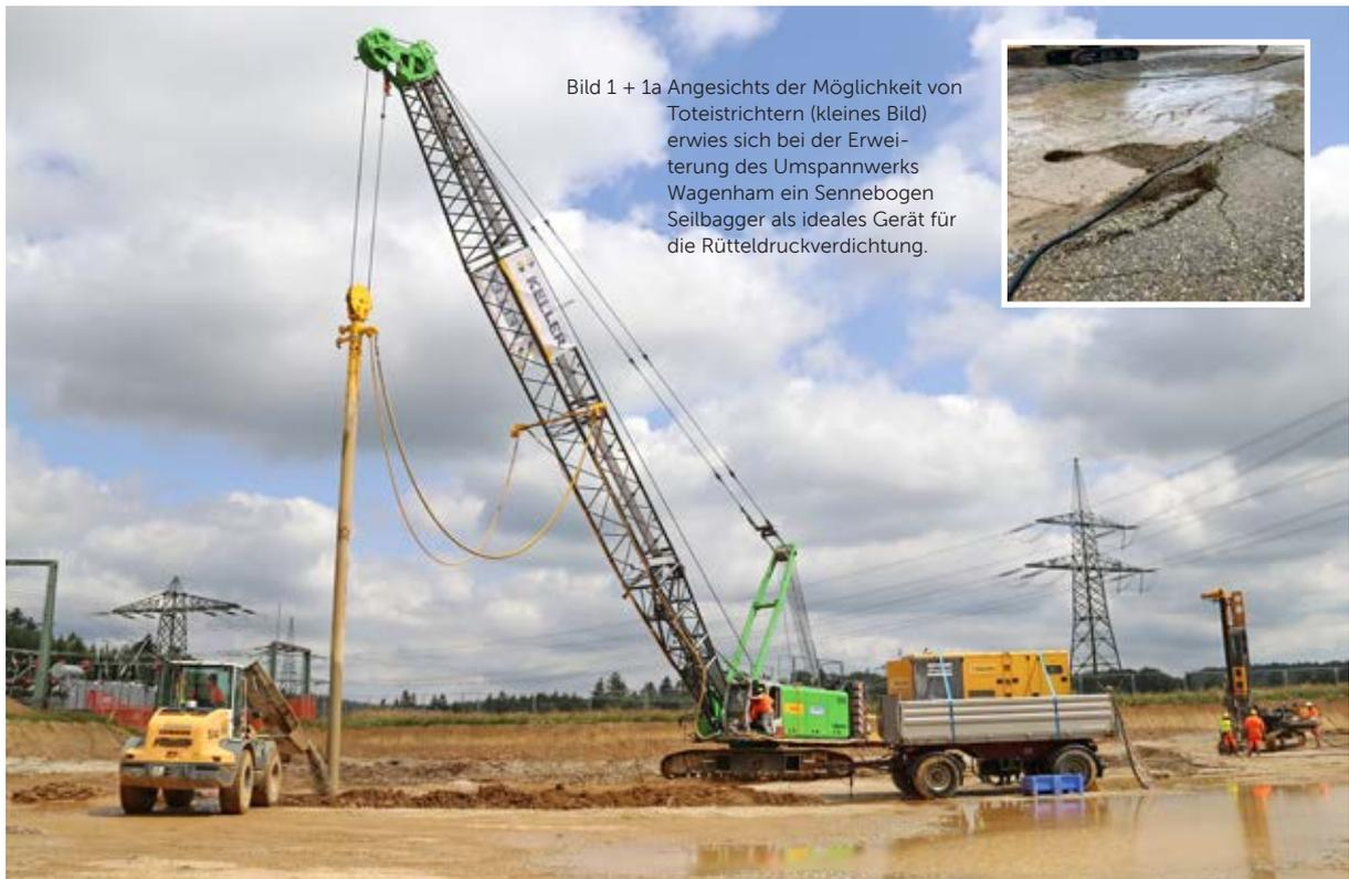
Bild 1 + 1a Angesichts der Möglichkeit von Toteistrichern (kleines Bild) erwies sich bei der Erweiterung des Umspannwerks Wagenham ein Sennebogen Seilbagger als ideales Gerät für die Rütteldruckverdichtung.
