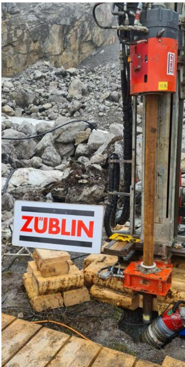
Abbildung 04: Bohrgerät SANDVIK DE142 auf Bohrung 06
