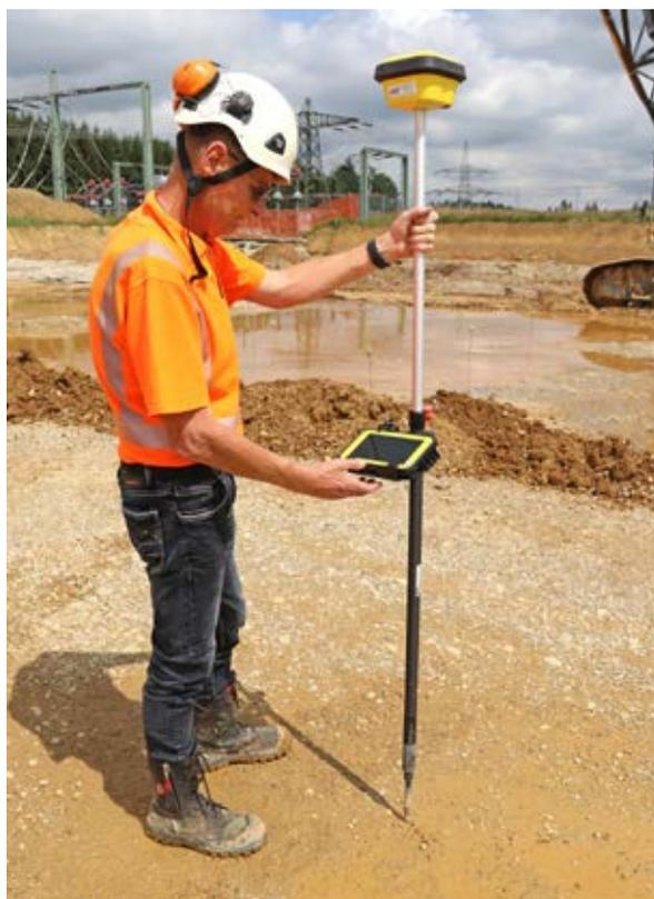
Bild 3 Bauführer Berthold Danner beim Festlegen und Markieren der Punkte für die Rütteldruckverdichtung.
