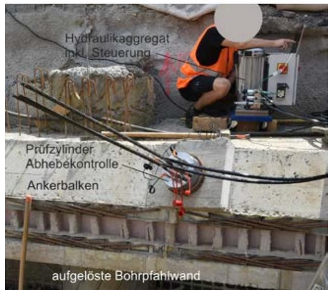
Abb. 1: Erprobung eines neuen Prüfequipment für Abhebekontrollen an einer Baugrubensicherung
