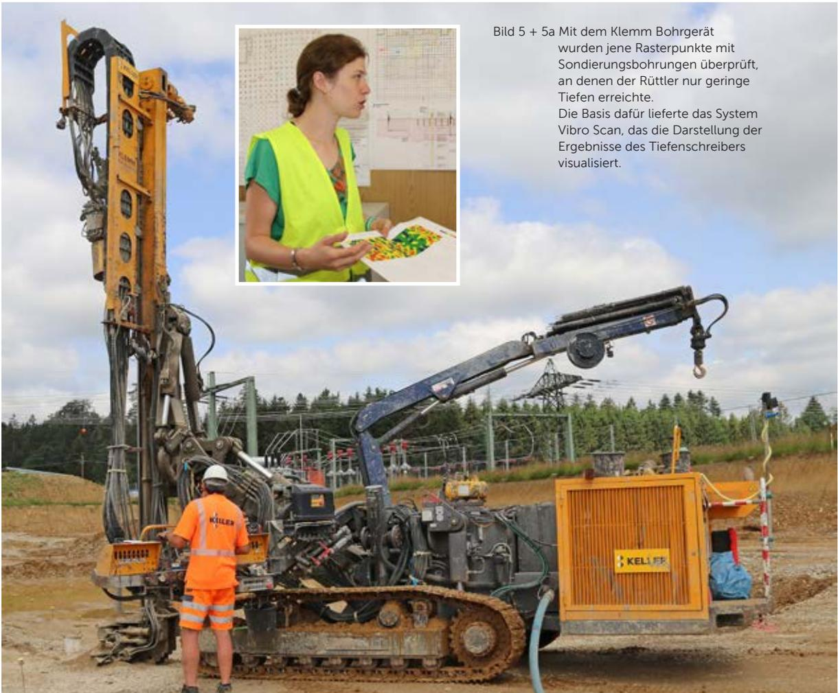
Bild 5 + 5a Mit dem Klemm Bohrgerät wurden jene Rasterpunkte mit Sondierungsbohrungen überprüft, an denen der Rüttler nur geringe Tiefen erreichte. Die Basis dafür lieferte das System Vibro Scan, das die Darstellung der Ergebnisse des Tiefenschreibers visualisiert.
