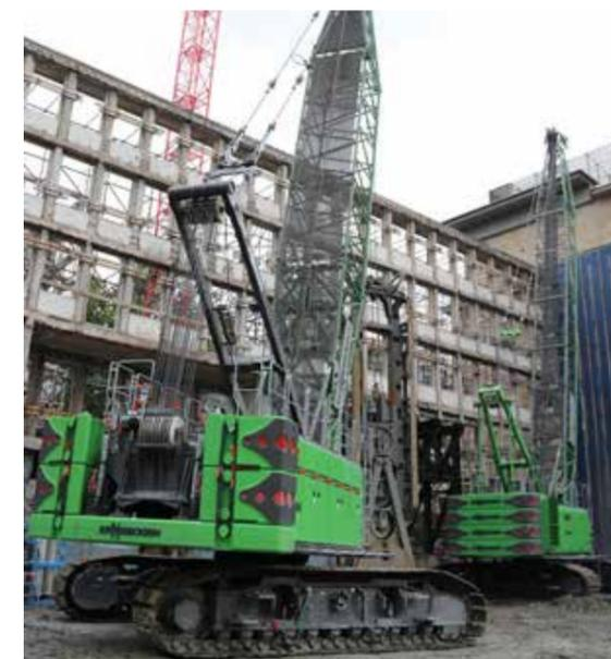
SENNEBOGEN Seilbagger im Schlitzwandeinsatz: links der 6140 R, der sich für Hebearbeiten bis 140t eignet, rechts einer der beiden 6130 R.
