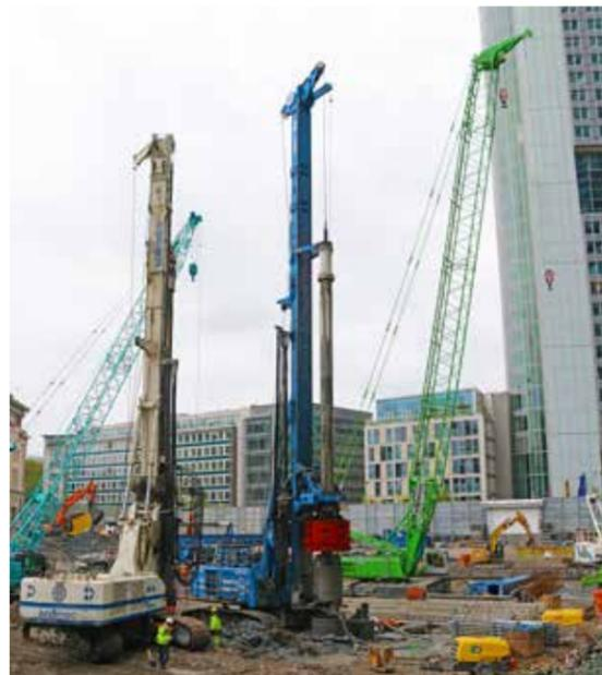
Seine Stärken – etwa das genaue Positionieren von Lasten durch die feinfühligste Steuerung – kann der SENNEBOGEN Raupenkran 5500 R, der in dieser Konfiguration für Hebearbeiten bis 180 t geeignet ist, beim Versetzen der Primärstützen in den Pfählen unter großer Ausladung voll ausspielen.
