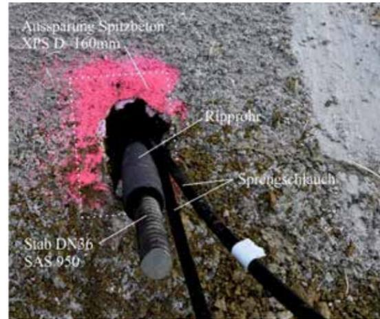
Abb. 3: Systemaufbau für ausbaubare Anker mittels Quellsprengstoff
