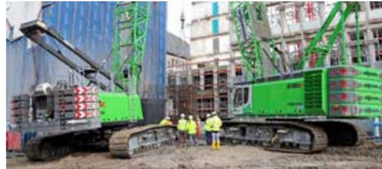
Einer der beiden Sennebogen Seilbagger 6130 R (rechts) beim Absenken eines Bewehrungskorbes. Er wird bei den Schlitzwandarbeiten unterstützt durch den SENNEBOGEN Raupenkran 3300 R (links).
