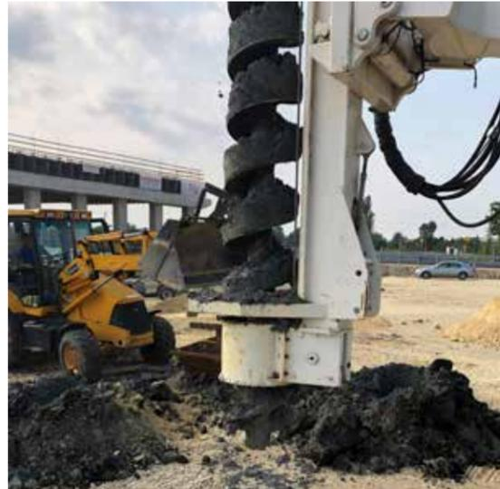
Impulsverdichter mit Schneckenbohrer
