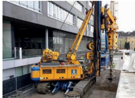
Pfahlherstellung mit einer BAUER BG 40 unter beengten Platzverhältnissen
