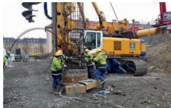
Einbau eines Bewehrungskorbs und Nachverpress-Injektionsschläuchen
