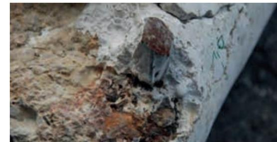
Abb. 2: Korrodierte Anschlussbewehrung im Bereich der Arbeitsfuge einer Winkelstützmauer
