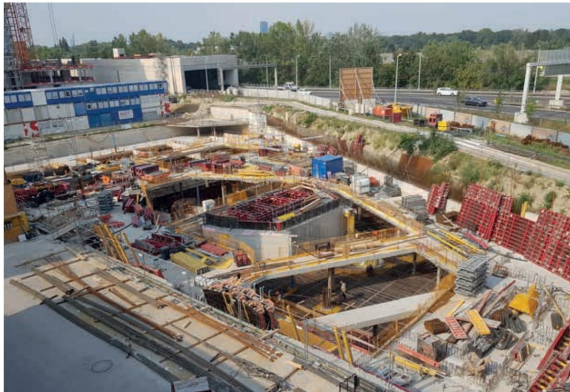
Abbildung 3: Baugrube in Deckelbauweise; Stand der Arbeiten (September 2019)
