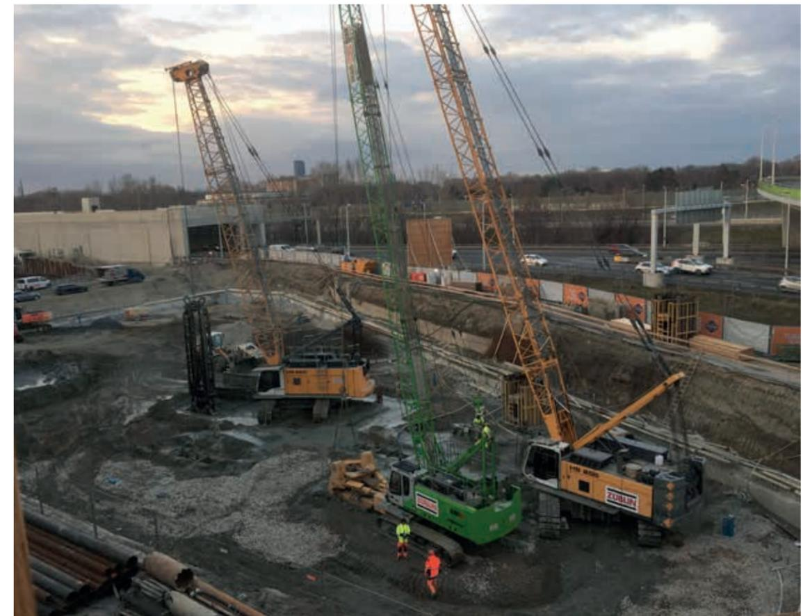
Abbildung 2: Baugrube ACG-Tower; Schlitzwand- und Brunnenherstellung
